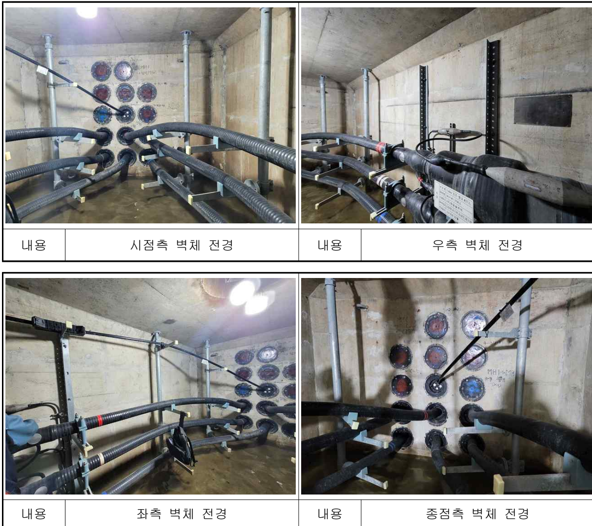
【사진 3.9】 진건~별내#1 전경
