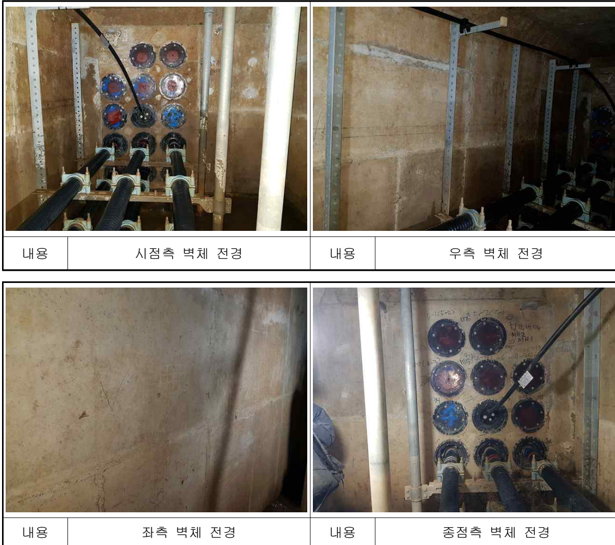
【사진 3.5】 진건~별내#0-1 전경
