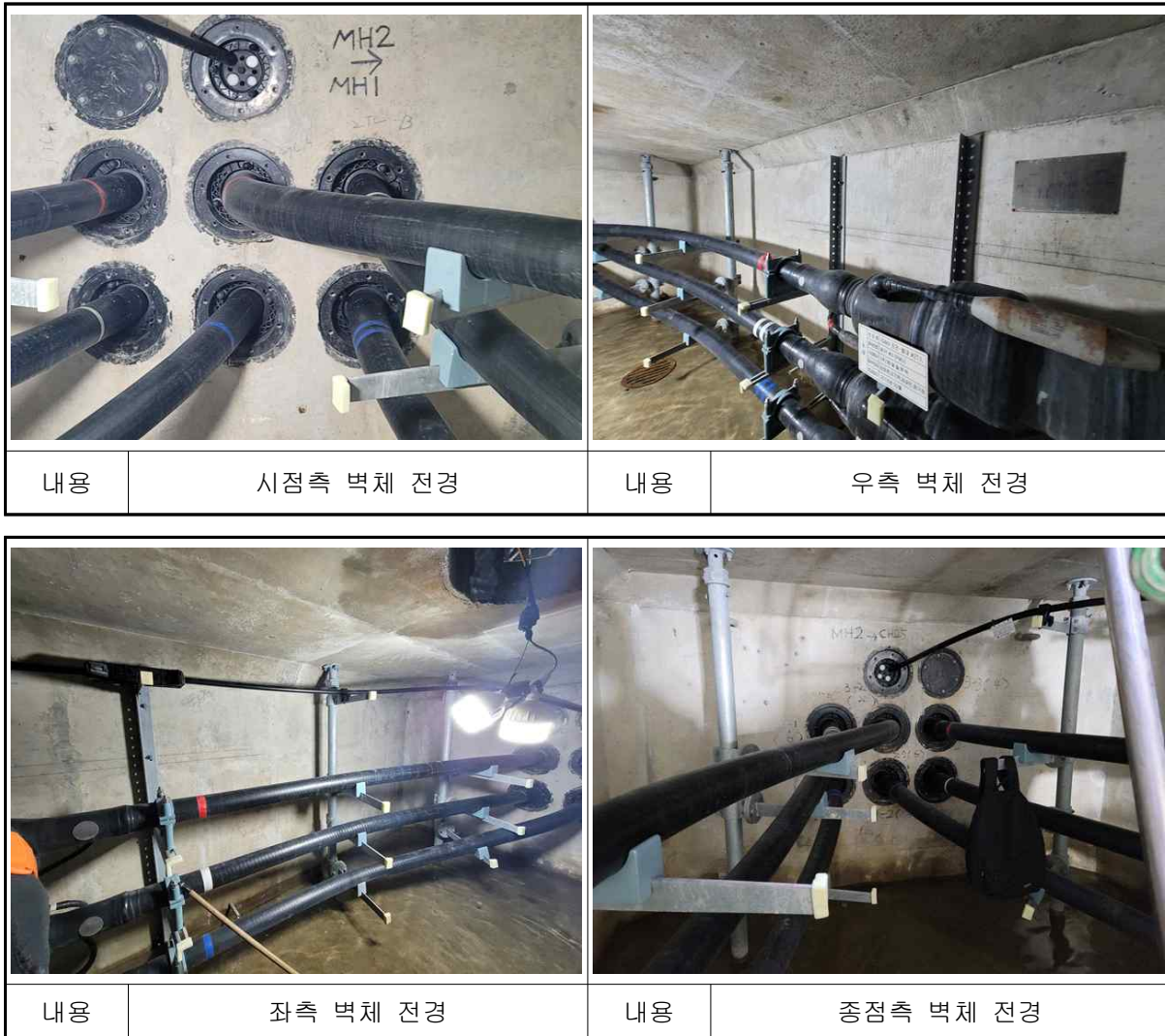
【사진 3.13】 진건~별내#2 전경
